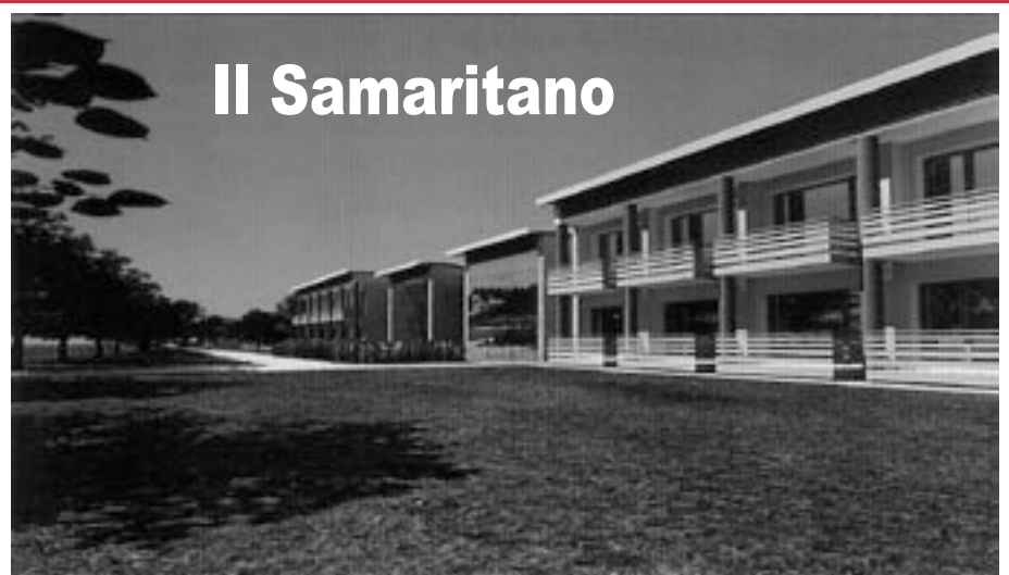
Perché il sogno diventi realtà la prima cosa che occorre è il sì del Comune
