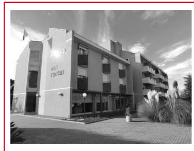
CENTRO DON VECCHI 3 Marghera via Carrara 10 57 alloggi
