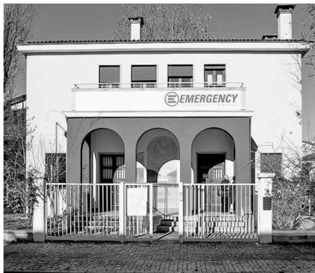
La sede di Emergency a Marghera
